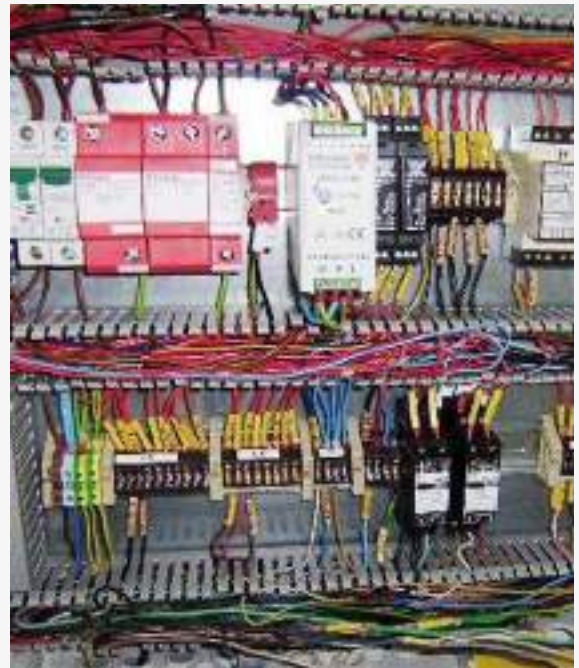
obr. 17 Správné připojení ochranné země
