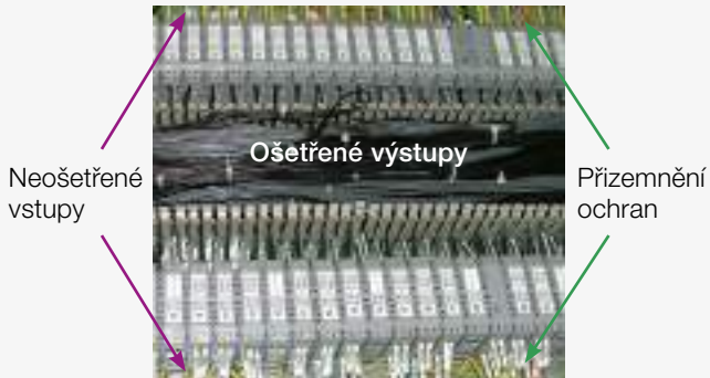
obr. 16 Chybné připojení ochranné země
