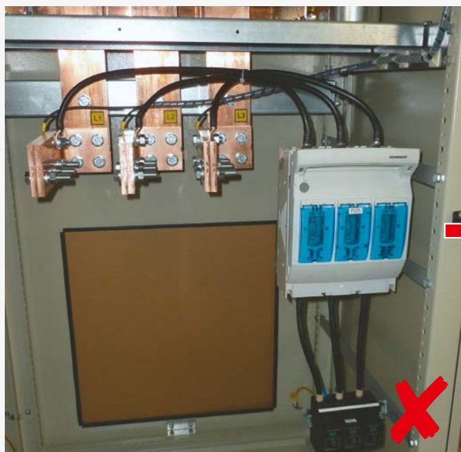
Před úpravou: Montáž SPD nespĺňuje podmínku – délka připojovacích vodičů
