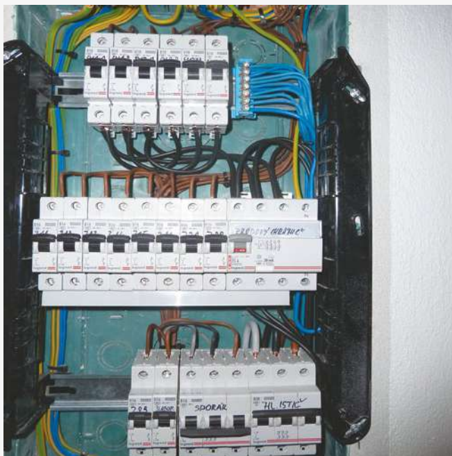
Rozváděč před instalací SPD
