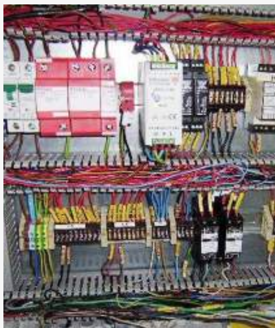
obr. 17 Správné připojení ochranné země
