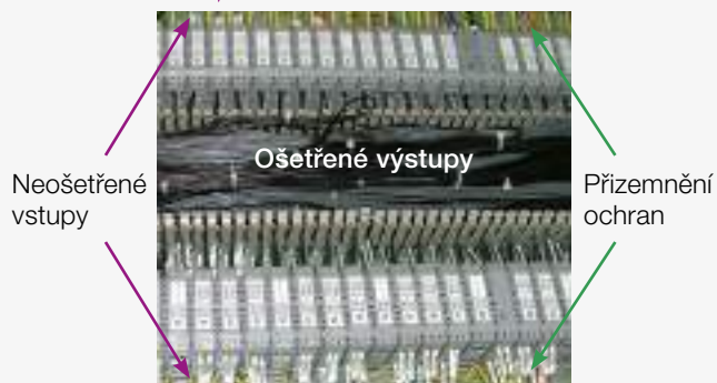
obr. 16 Chybné připojení ochranné země
