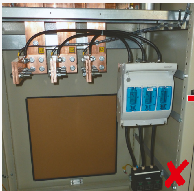
Před úpravou: Montáž SPD nesplňuje podmínku – délka připojovacích vodičů
