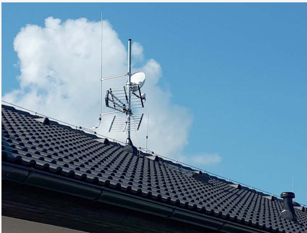
obr. 9 Příklad správné realizace přijímacího anténního systému na rodinném domku (dle principů obrázku 2).
