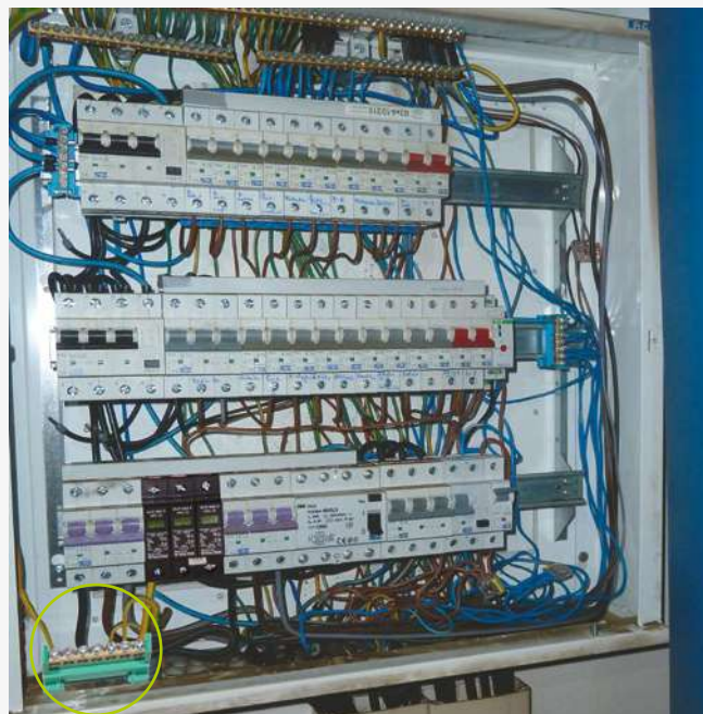
Správně: přidáním svorkovnice (obr. 14b) a zapojením vodiče PEN do svorkovnice se splňují podmínky ČSN 33 2000-5-534.
