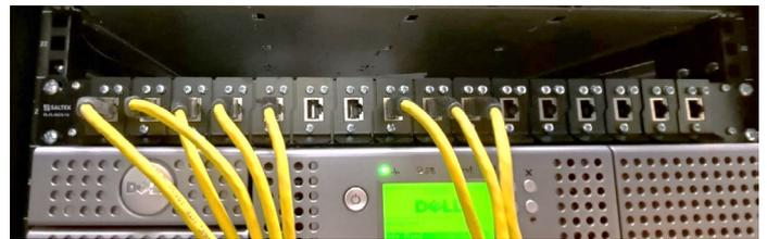
Abb. 6 Mehrkanaliger Schutz mit Plug&Play-Modulen in die DL-PL-RACK-1U Einsteckbox
