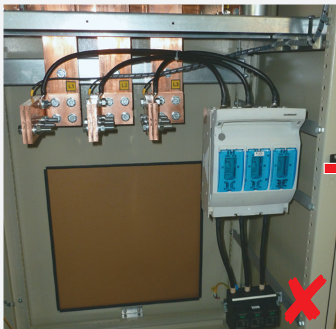
До изменений: способ установки УЗИП-а не выполняет предъявляемых к проводам подключения УЗИП-а требований по длине.
